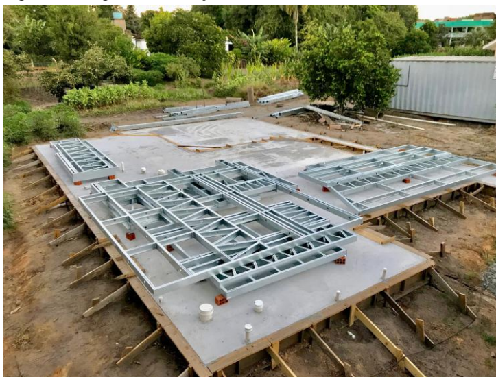
Figura 2: Imagem da fundação radier, utilizada na estrutura LSF.
