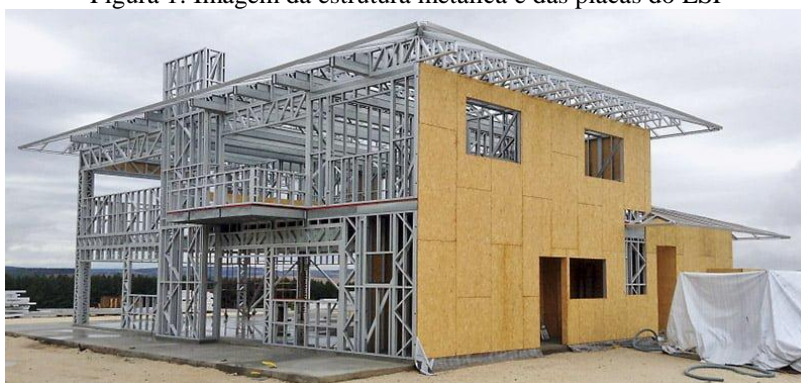
Figura 1: Imagem da estrutura metálica e das placas do LSF
